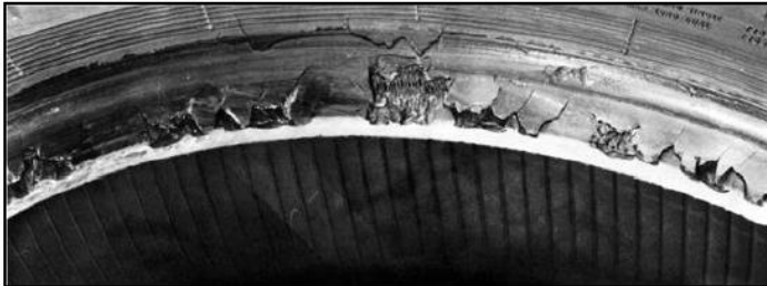
Fotoğraf 3: Aşırı ısınmadan kaynaklı damak hasarı başlangıcı
